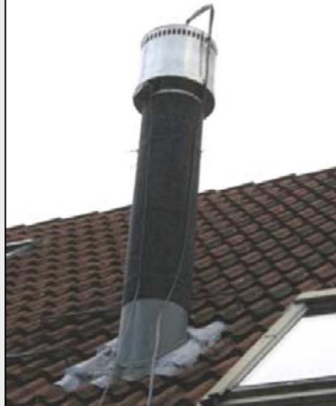
Rys. 2. Elektrofiltr mocowany na kominie: 1) zasilanie, 2) izolator, 3) elektroda, 4) uziemienie [23]/ Электрофiльтр, встановлений на димоході: 1) підключення, 2) ізолятор, 3) електрод, 4) заземлення
